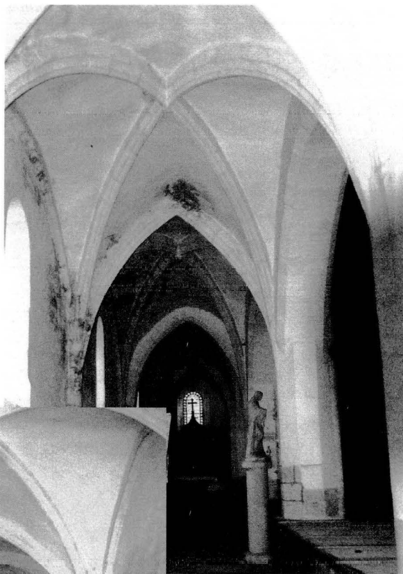
Bas-côté nord. - Vue vers l'est
