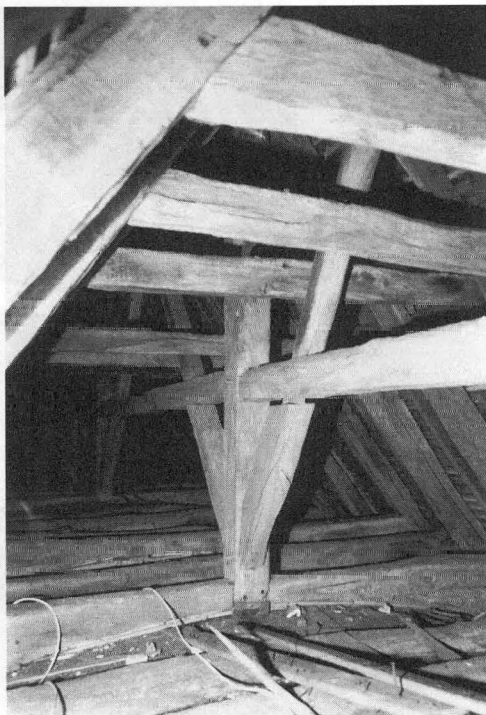
Charpente : parties supérieure et inférieure.
