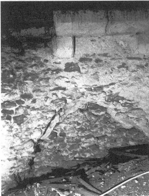
Mur nord de la nef : ancienne corniche à modillons et fenestrage bouché.
