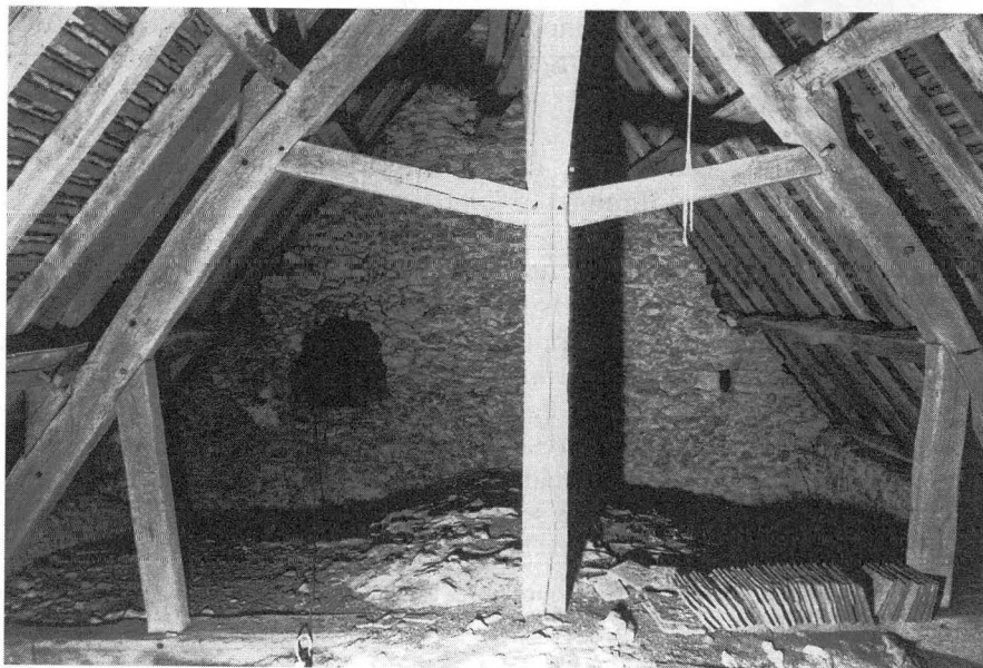
Ferme derrière laquelle se situe le mur diaphragme
