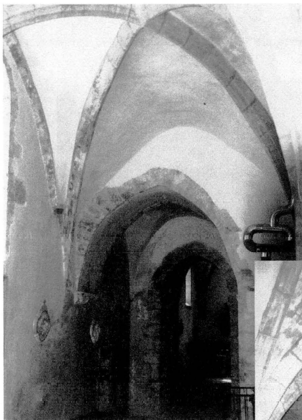
Bas-côté sud. - Vue vers le clocher
